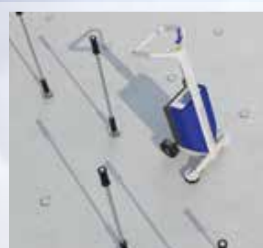
6. Las het dakmembraan op de GuardianWeld™ drukverdeelplaten
