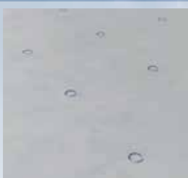
4. Markeer de bevestigingspunten op het membraan
